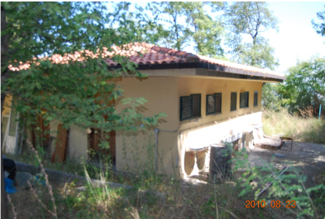
Edificio 5 Unità servizi
